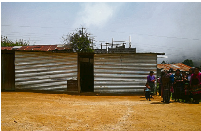
Bisher findet der Unterricht in Pacamposanto in solchen Wellblechhütten statt.
