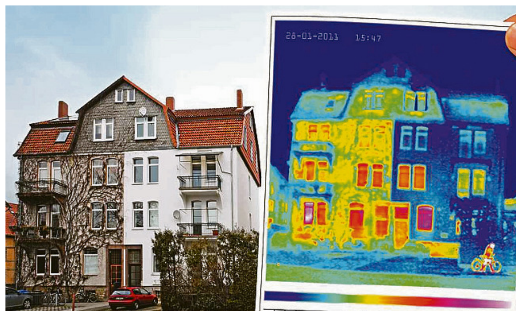
Mit Hilfe einer Thermografie lassen sich Wärmelecks einfach entdecken. Die Gelsenwasser AG bietet dazu auch in diesem Winter eine besondere Aktion an. Foto: Gelsenwasser
